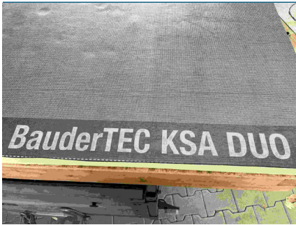
Montage Bauder TEC KSA
