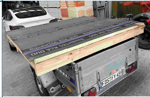
Montage Bauder TEC KSA
